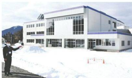
花輪高敷地内に完成した実習棟の外観
