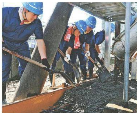
生コンでスコアボードの支柱を固定する生徒
