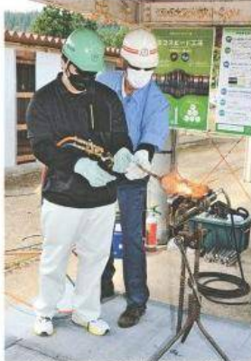
手ほどきを受けながらガス圧接の作業を体験する生徒(左)
